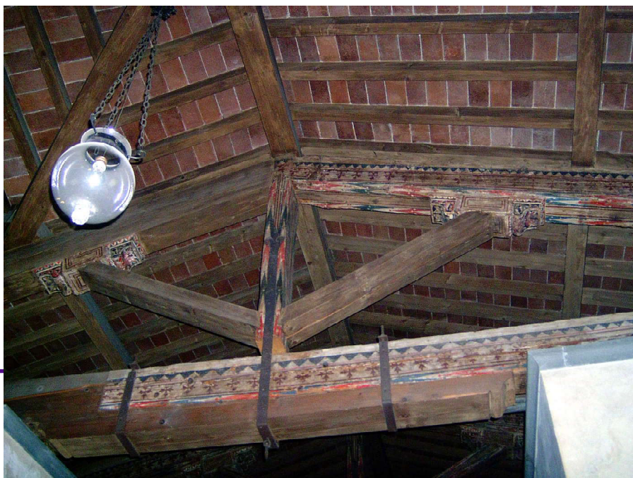
Le capriate del tetto dei dormitori, foto di P.I.M., 2006.
